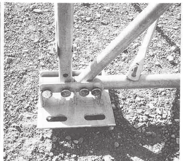
支点(固定金具 B-JY)取付部
