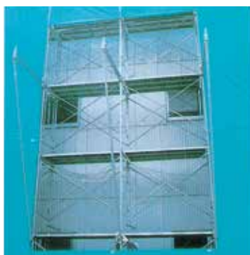
斜材を持ち上げピンをセットし、カブラーを仮止め
