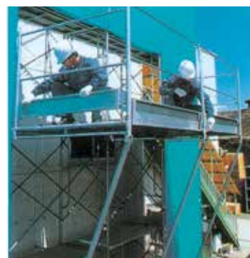
幅木 S をはめて、手摺柱 N のボルトを締める。
