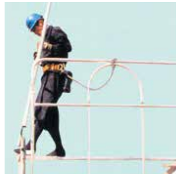
▲足場の先端部に建わくを取り付ける場合にはスカイガードの手すりに安全帯を取り付けます。
