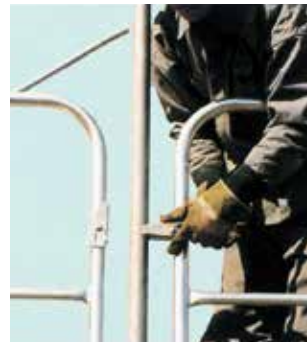
▲建わくに上部金具を突きあてます。
