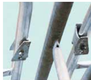
▲建わくを取り付けた時に上部金具は垂直状態になっています。
