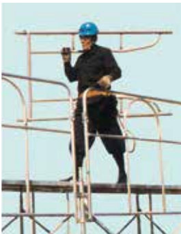
▲建わくを肩に担ぎ、片手はスカイガード手すりにつかまりながら移動中。
