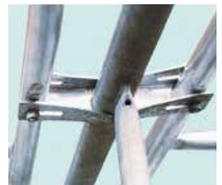
▲上部金具を上へ引き上げ、建わくに水平に突きあてた状態。
