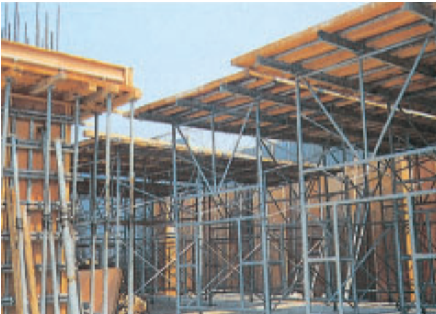
フラットスラブ使用現場
