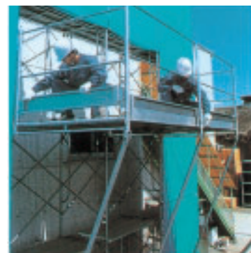
幅木Sをはめて、手摺柱Nのボルトを締める。
